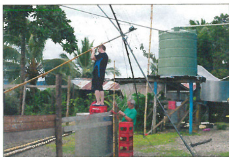
Eine wacklige Angelegenheit – Aufbau des Beams für H40T in Lata auf Santa Cruz
