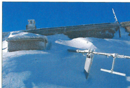
Defekte Masthalterung bei HB9ZF-1 Foto: HB9EVE
